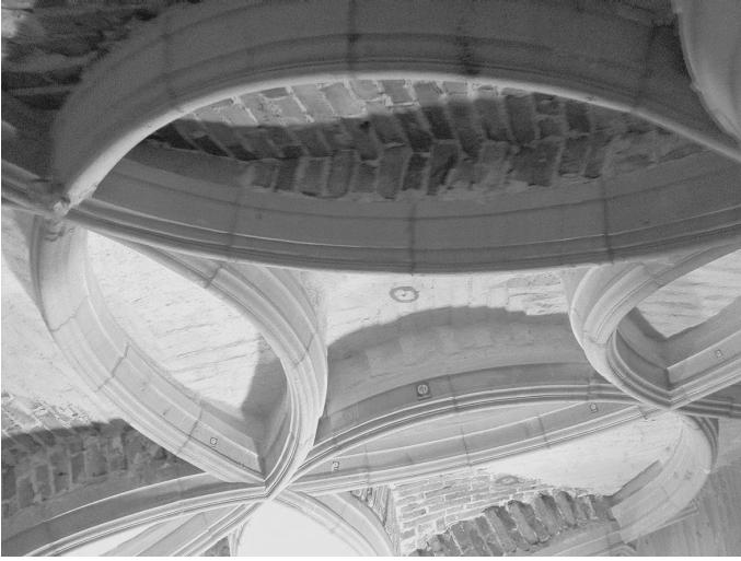
Abbildung 4: Probesegment zum Einbau des Schlingrippengewölbes 2011
