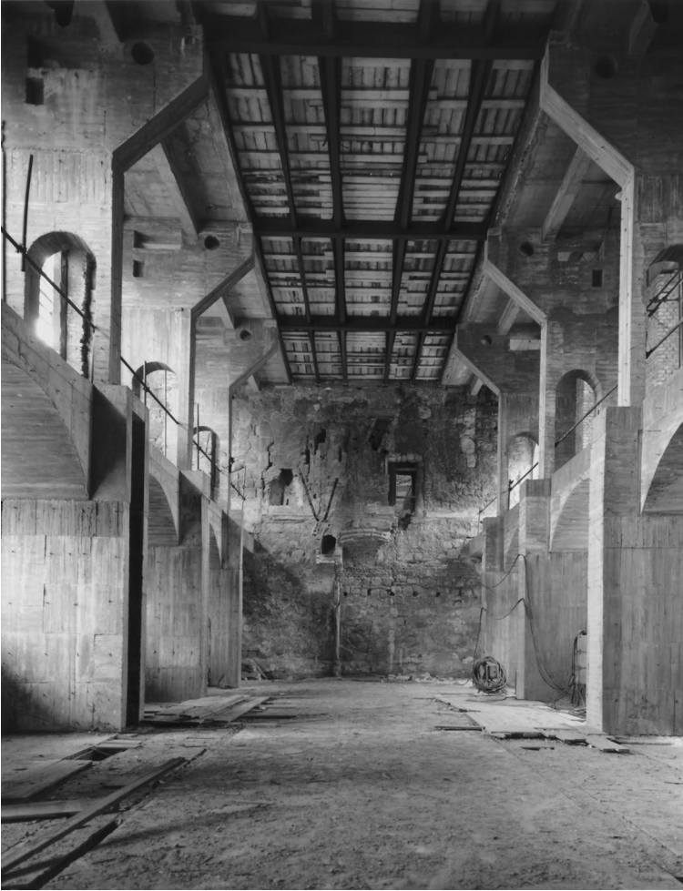
Abbildung 3: Rohbau der Schlosskapelle mit Längsemporen um 1995, Blick nach Osten. Foto: Landesamt für Denkmalpflege Sachsen
